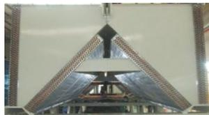
Теплообменник М-образной формы состоит из бесшовных медных труб с внутренней накаткой и ребер из алюминиевого сплава с гидрофильным покрытием. Смотровое стекло с цветным индикатором служит для контроля содержания влаги в линии, а также уровня заправки хладагента.
